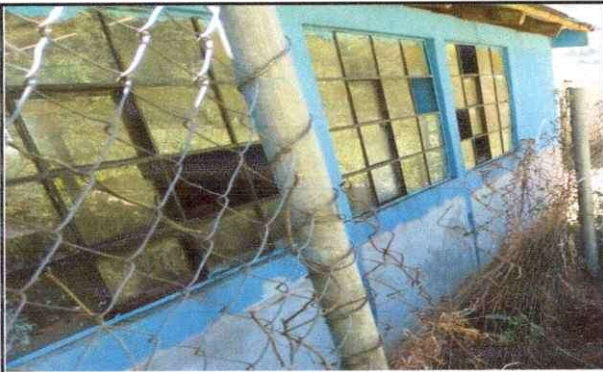
Foto 3: SUSTITUCION DE VENTANA
