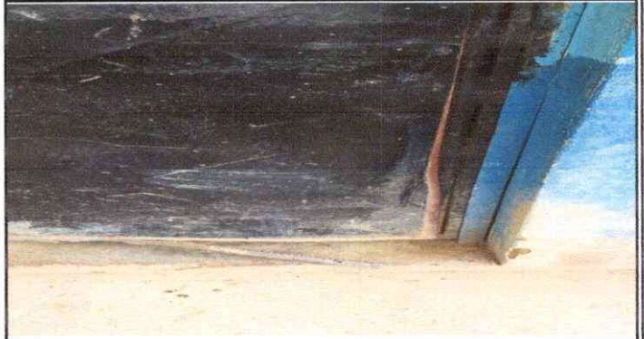
Foto 2: SUSTITUCION DE PUERTA POR DETERIORO
