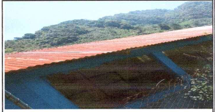
Foto 4: CUBIERTA DE LAMINA
